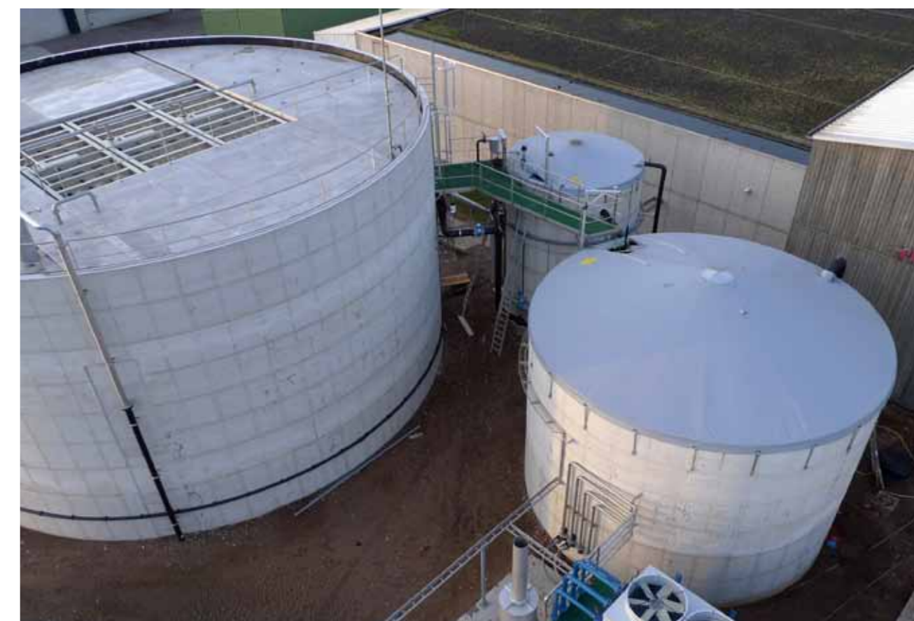
Een primeur: anaerobe compostering waarbij met het gewonnen biogas elektrische energie opgewekt wordt.
